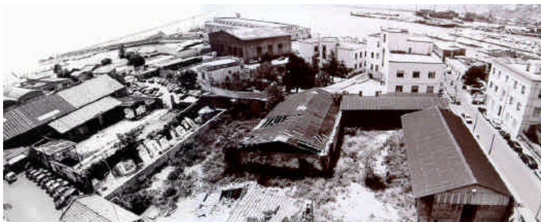
Area di Santa Teresa prima delle demolizioni
